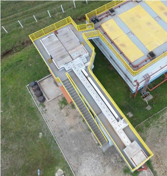
Figura 121 - Canal de chegada de esgoto bruto.
