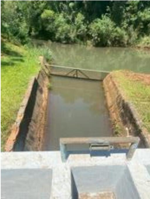
Figura 34 - Poço de sucção das bombas.
