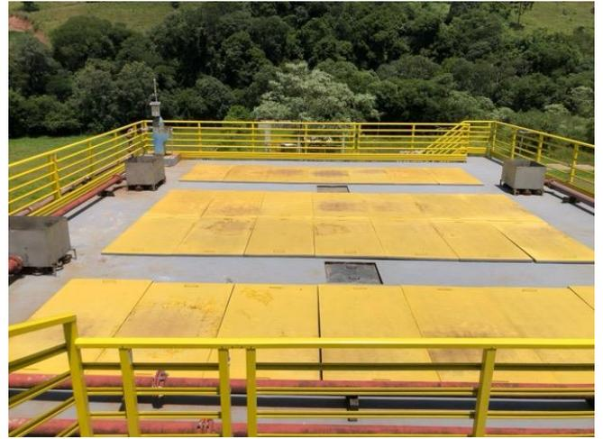
Figura 124 - Cx. distribuidora de vazão reator UASB.
