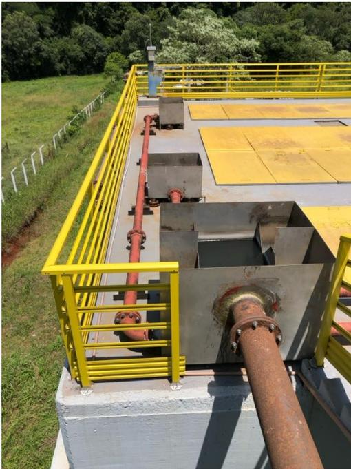
Figura 125 - Detalhe da cx. distribuidora de vazão.
