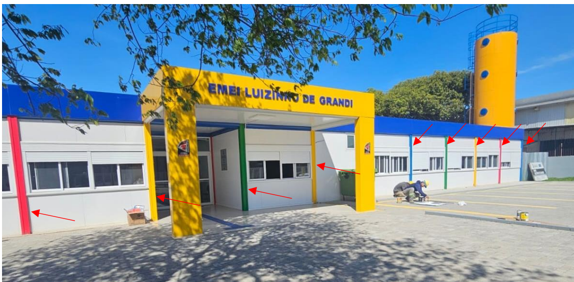
Figura 01 – Ambiente Externo da Estrutura Modular da Metalpox Indústria
