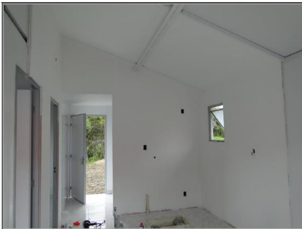
Figura 85 – Vista geral do revestimento em chapas de gesso acartonado (protótipo em fábrica).
