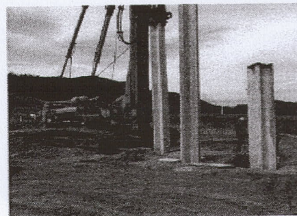
Figuras 5 e 6 – Exemplos de execução de estacas cravadas
