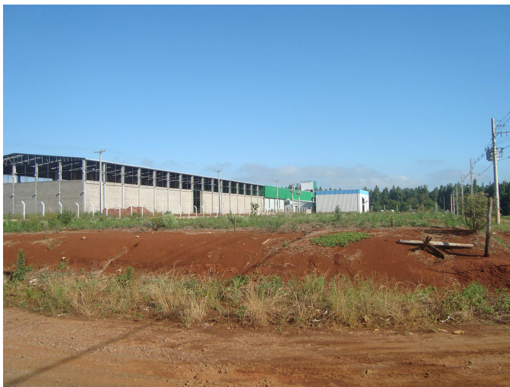
Figura 2- FOTO DO LOTE Nº 2 DA ÁREA INDUSTRIAL - (vista da Rua "B").
