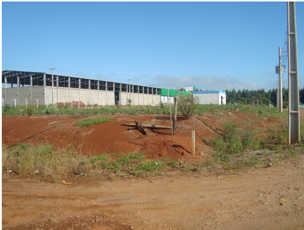
Figura 1- FOTO DO LOTE Nº 2 DA ÁREA INDUSTRIAL - (vista da Rua "B").
