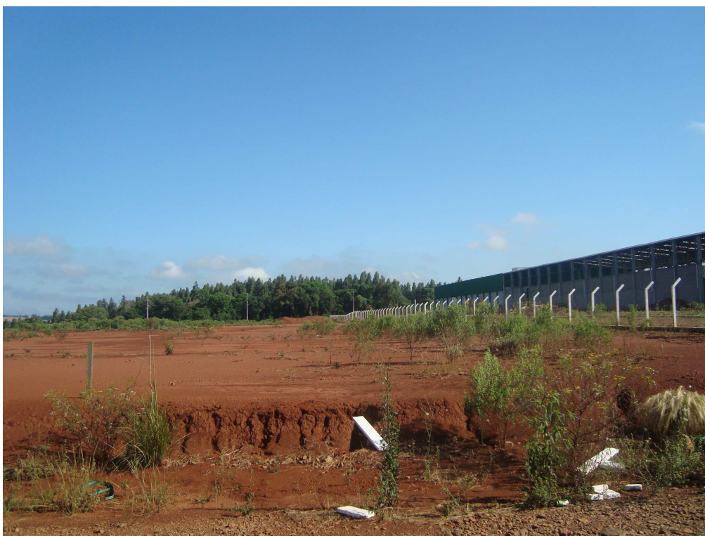
Figura 4-FOTO DO LOTE Nº 4 DA ÁREA INDUSTRIAL - (vista da Rua "B").
