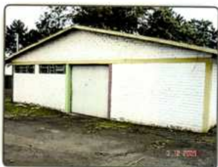
CÂMERA FIXA DAY/NIGHT - 10 PAVILHÃO 03 - ENTRADA
