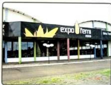
CÂMERA FIXA DAY/NIGHT - 14 PAVILHÃO 02 - ENTRADA
