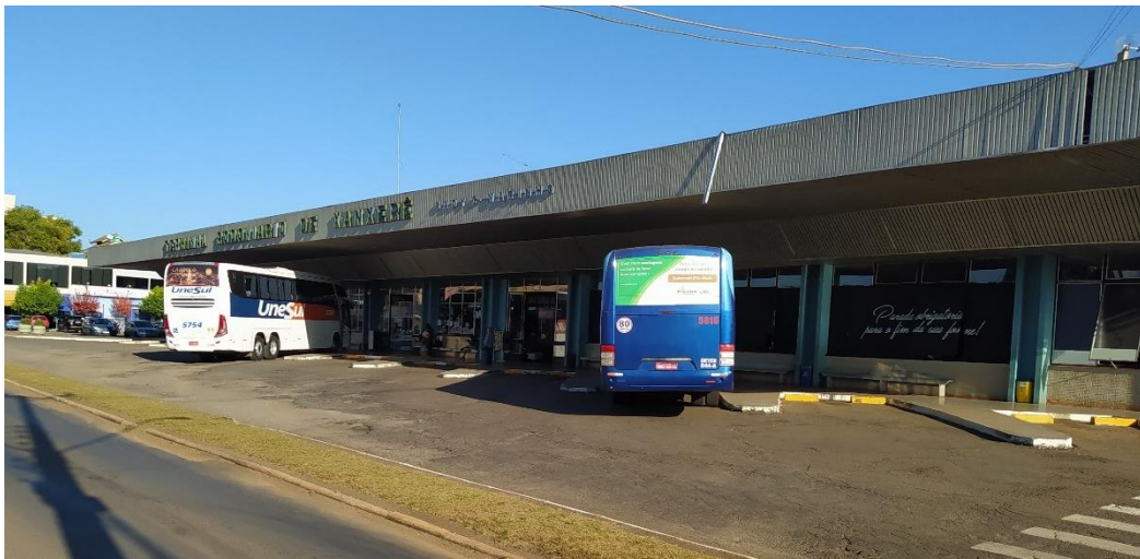
Figura 24. Terminal Rodoviário de Xanxerê. Fonte: o autor (2022)
