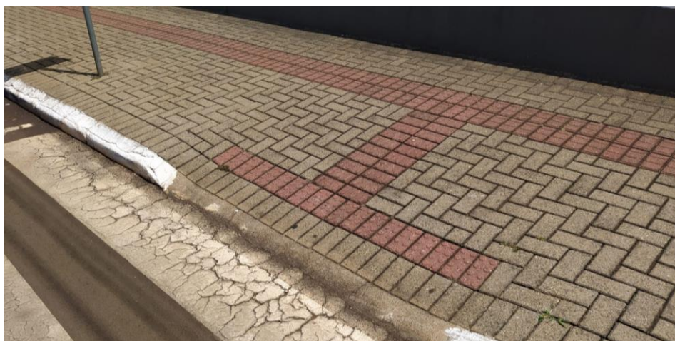
Figura 37. Calçada com acessibilidade: rua José de Miranda Ramos. Fonte: autor (2022)
