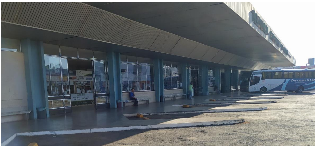
Figura 25. Terminal Rodoviário de Xanxerê. Fonte: o autor (2022)
