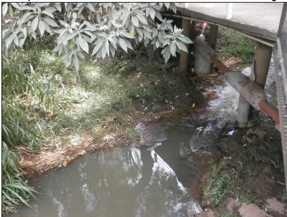
Figura 150: Aspecto do rio Xanxerê no Ponto 3 na Rua Nereu Ramos com largura de 6 m.
