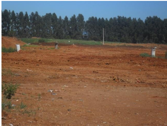
Figura 88: Sistema de Queima de Gases em célula desativada.
