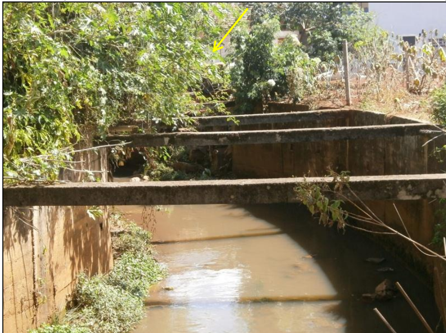
Figura 142: o rio Xanxerê Próximo a Rua Irineu Bornhausen (Rua Athanásio Antônio). Largura de 6 m e Leito com Blocos de Concreto. Destaque para a entrada do afluente da Rua Emilio Allet (Bairro Veneza).
