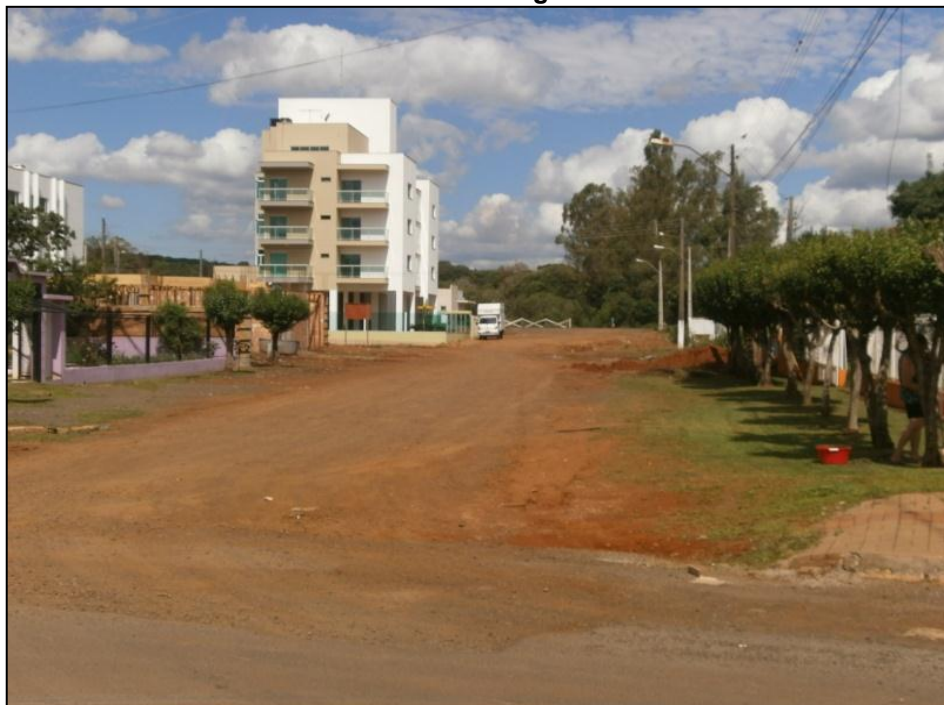
Figura 155: Aspecto do Ponto 4 (final da Rua Artur Dambroso e Rua Olímpio Júlio Tortato) Onde Ocorrem Alagamentos.
