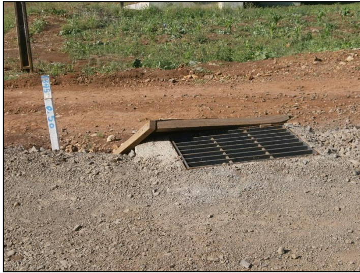
Figura 125: Pavimentação de Bairros de Xanxerê no Final de 2012. Detalhe para Execução de Boca-de-Lobo na Via.
