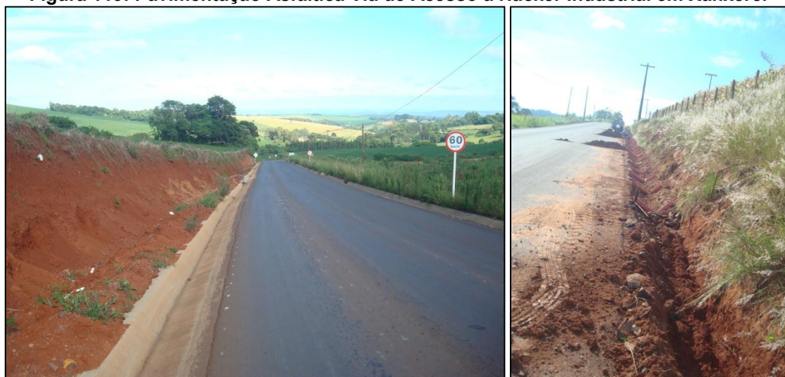
Figura 119: Pavimentação Asfáltica Via de Acesso a Hacker Industrial em Xanxerê.
