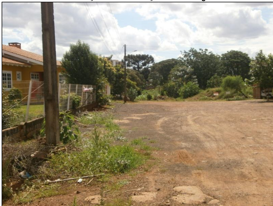
Figura 156: Ponto 4 (Final da Rua Artur Dambroso e Rua Olímpio Júlio Tortato) Locais Onde Há Modificações nas Tubulações de Drenagem.
