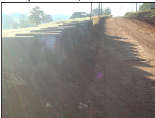
Figura 121: Pavimentação Asfáltica da Via de Acesso a Hacker Industrial em Xanxerê. Detalhes para as Tubulações Utilizadas.
