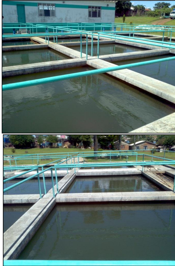
Figura 35: Decantadores Simples.
