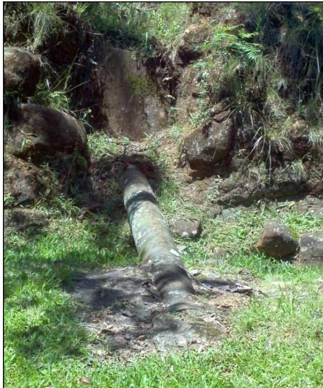
Figura 24: Adutora de Água Bruta.
