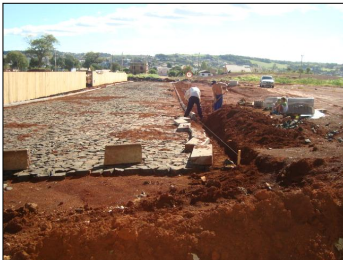
Figura 116: Pavimentação com calçamento do Loteamento Andorinhas em Xanxerê. Detalhe Para Boca-de-Lobo da Via.
