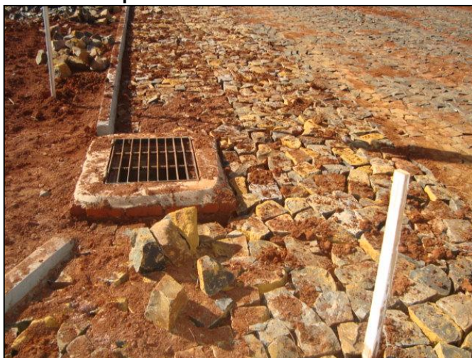
Figura 117: Pavimentação com calçamento do Loteamento Andorinhas em Xanxerê. Detalhe para Boca-de-Lobo da via.
