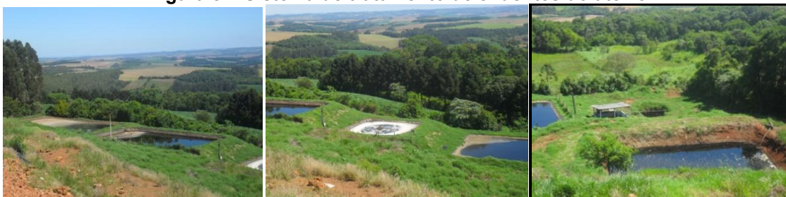
Figura 87: Sistema de tratamento de efluentes do aterro.
