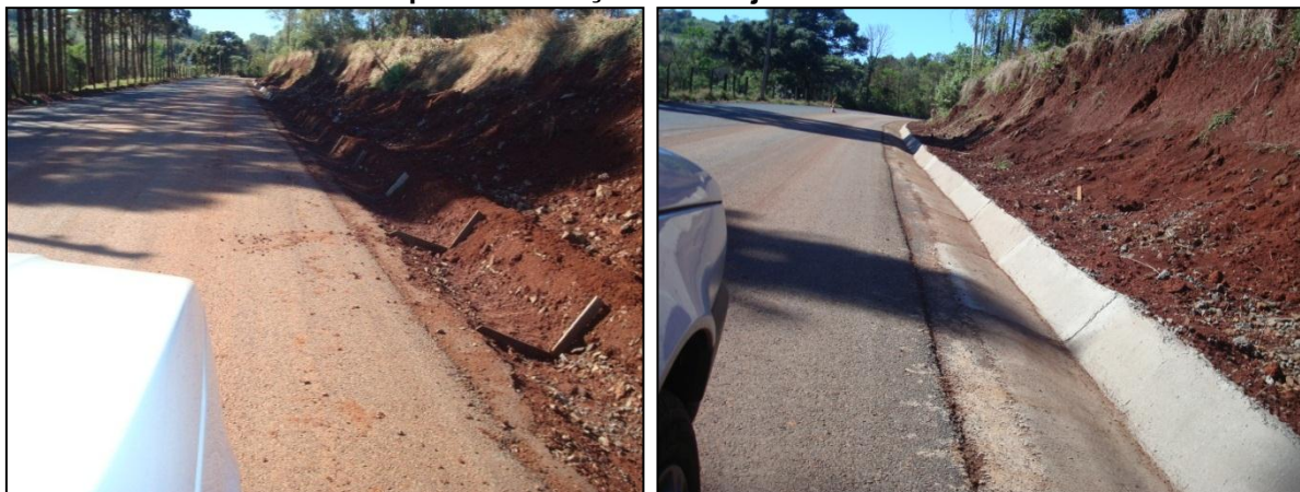
Figura 120: Pavimentação Asfáltica da Via de Acesso a Hacker Industrial em Xanxerê. Detalhes para a Execução das Sarjetas da Via.
