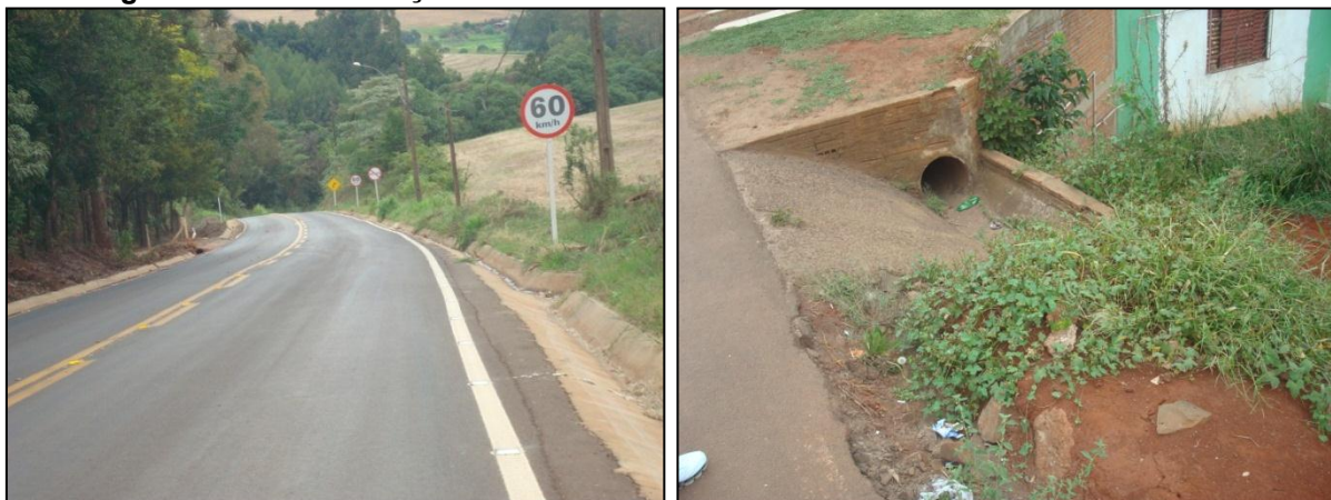
Figura 118: Pavimentação Asfáltica Via de Acesso a Hacker Industrial em Xanxerê.
