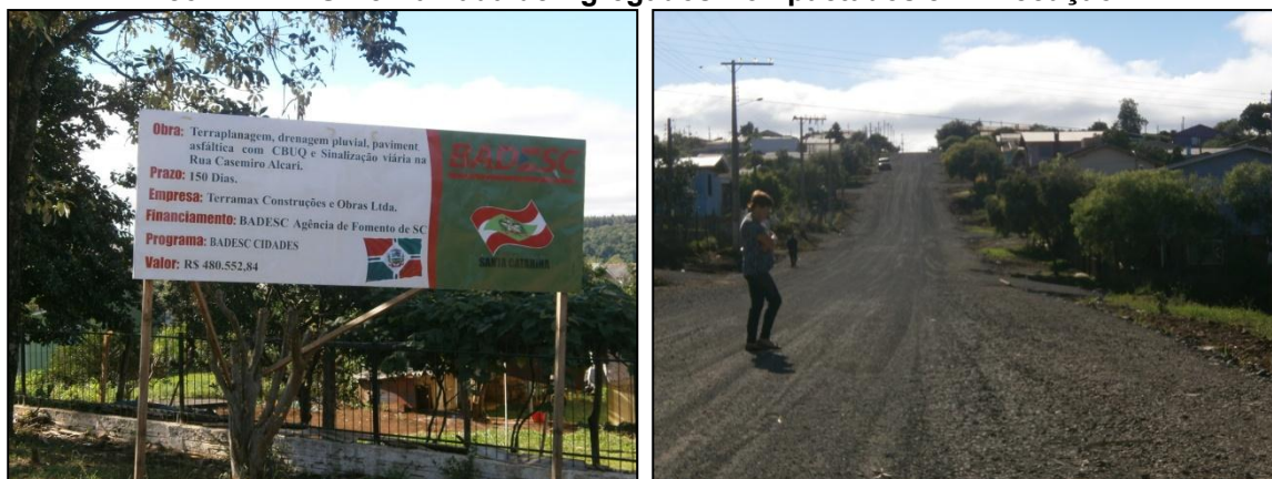
Figura 123: Pavimentação de Bairros de Xanxerê no Final de 2012. Detalhe Placa de Convênio com BADESC e Camada de Agregados Compactados em Execução.
