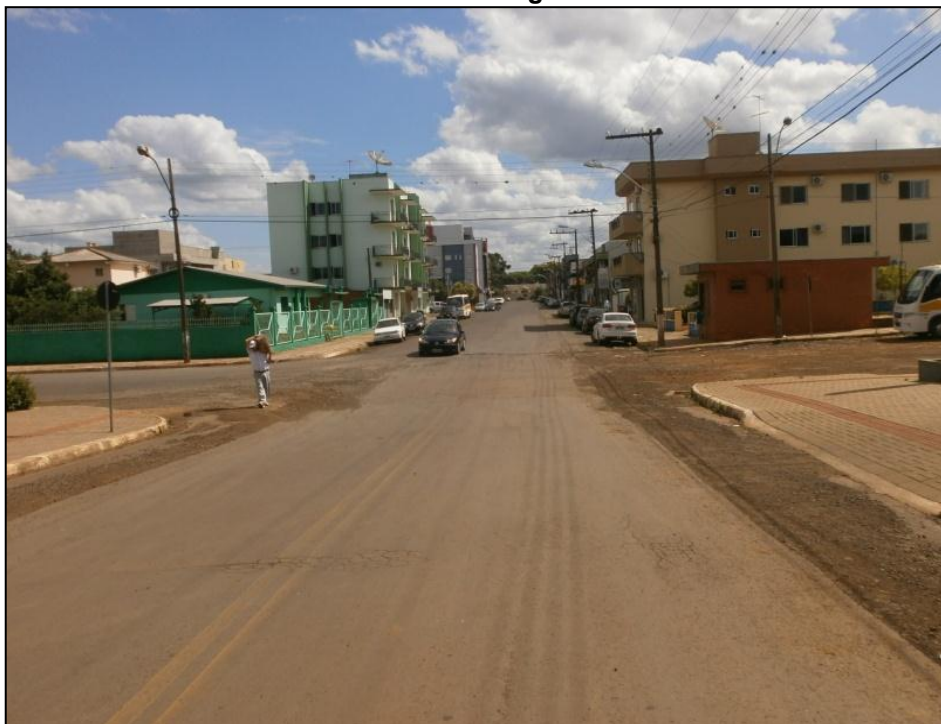
Figura 154: Aspecto do Ponto 4 (Final da Rua Artur Dambroso e Rua Olímpio Júlio Tortato) onde Ocorrem Alagamentos.
