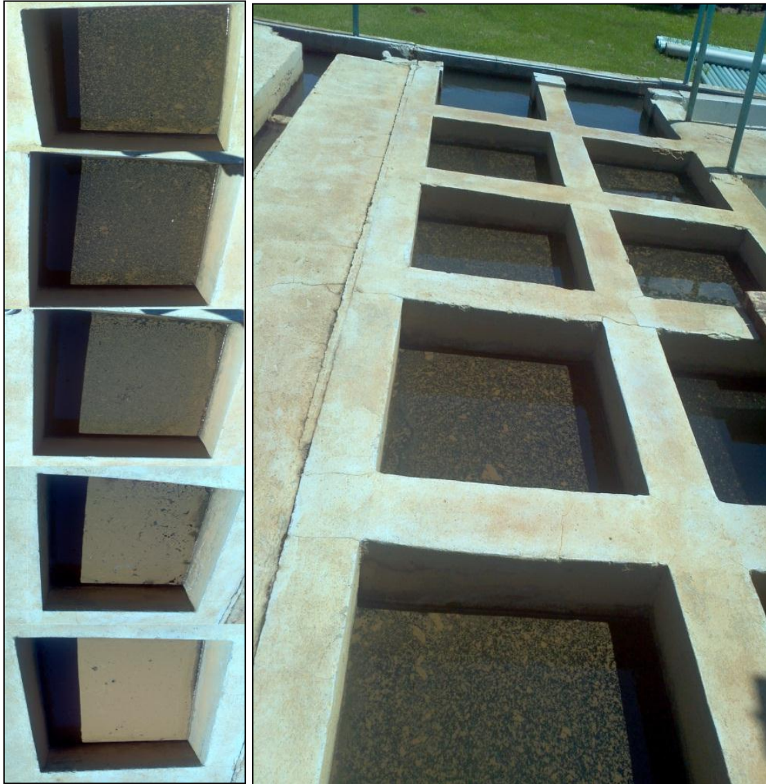
Figura 34: Sequência de Formação dos Flocos.
