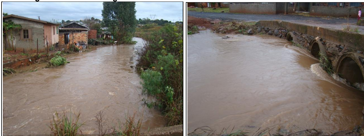
Figura 112: Nível de Água do Rio Xanxerê em Junho de 2011 no Bairro Vila União.
