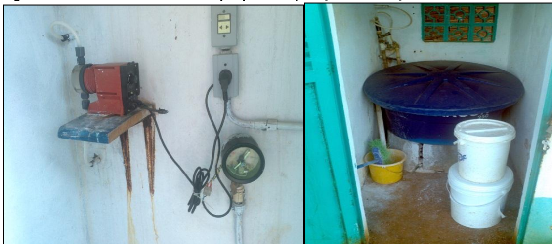
Figura 27: Bomba Dosadora e Tanque para Preparação da Solução de Cloro e Flúor – P1.
