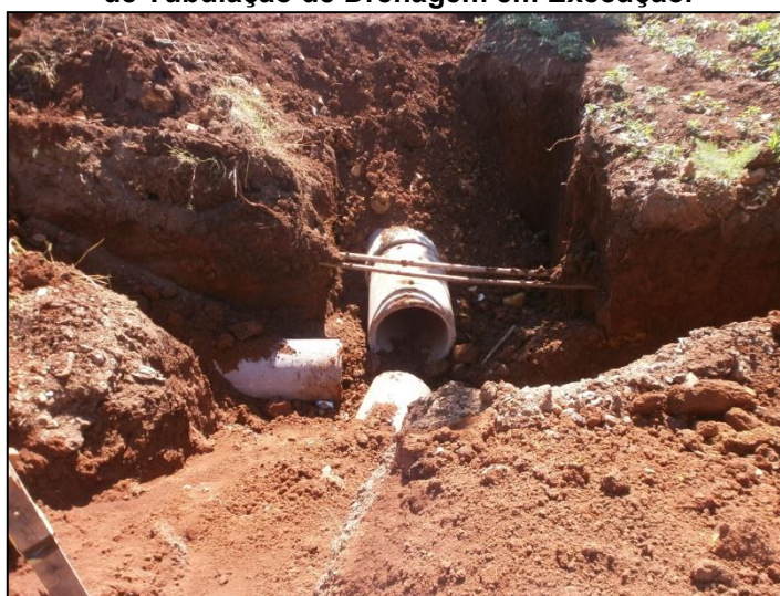
Figura 124: Pavimentação de Bairros de Xanxerê no Final de 2012. Detalhe para Assentamento de Tubulação de Drenagem em Execução.
