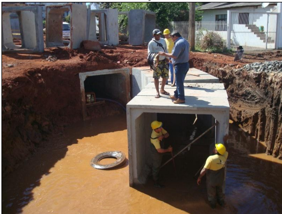
Figura 147: Obras realizadas na Rua Irineu Bornhausen e Athanásio Antônio em 2010. Execução.
