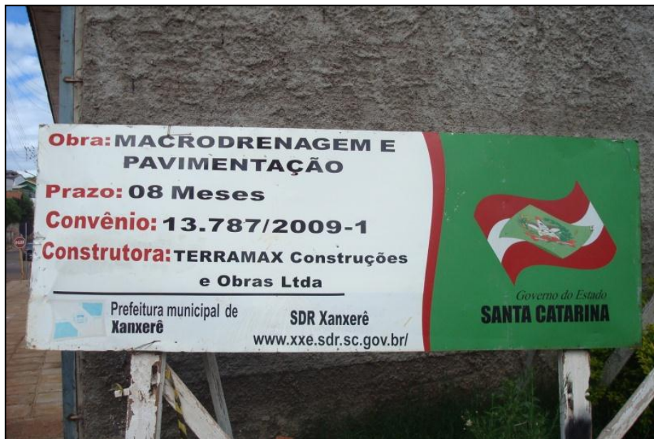
Figura 144: Obras Realizadas na Rua Irineu Bornhausen e Athanásio Antônio em 2010.
