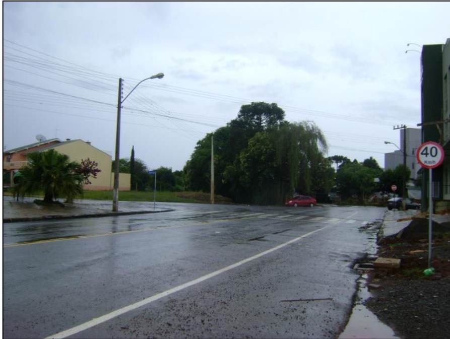
Figura 141: Visão Geral do Encontro entre as rRuas Irineu Bornhausen, Athanásio Antônio. Vista do final da Rua Athanásio Antônio. O Afluente do rio Xanxerê Passa Sob esse Cruzamento.
