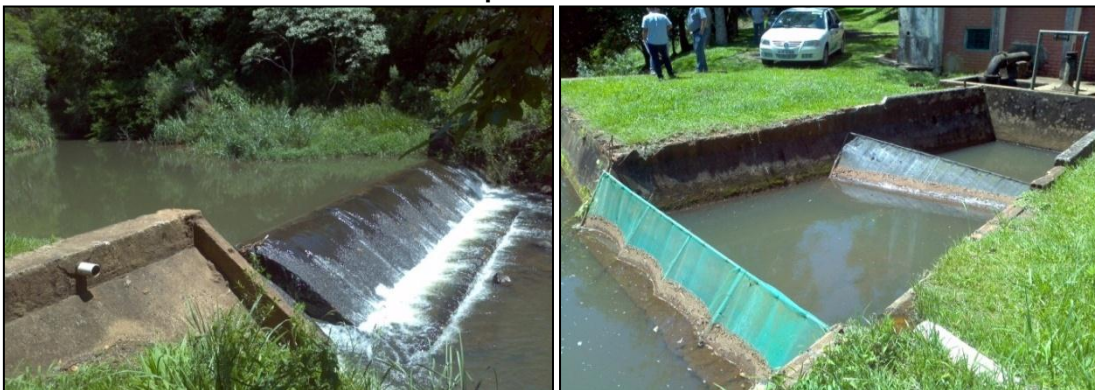
Figura 22: Barragem de Nível e o Canal para Tomada de Água com as Redes de Retenção para Sólidos.
