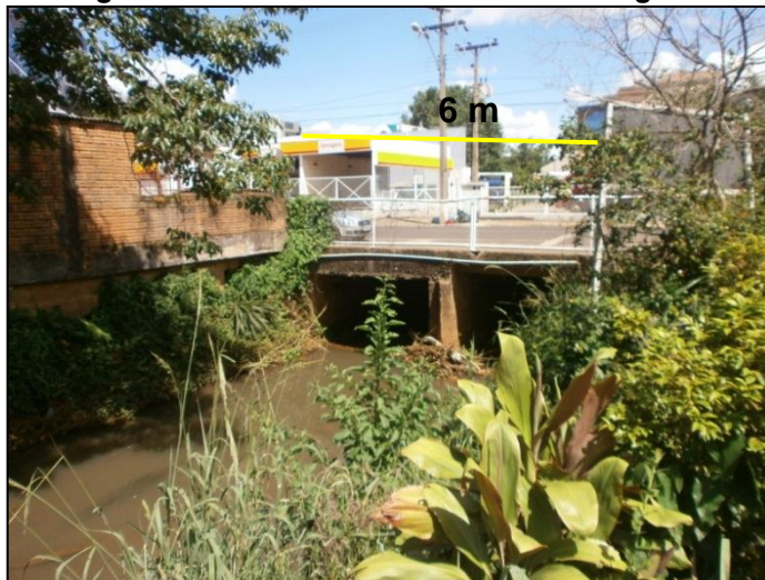
Figura 135: Aspecto do rio Xanxerê no Ponto 1 Visto de Montante a Jusante. Passagem da Água sob a Av. La Salle com 6 m de Largura.
