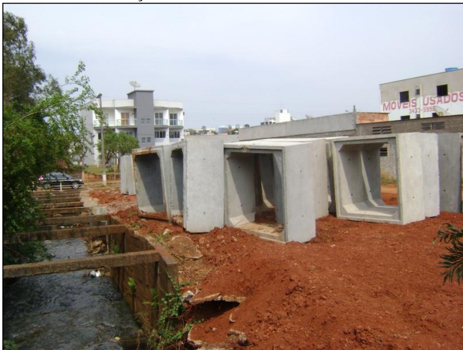
Figura 146: Obras Realizadas na Rua Irineu Bornhausen e Athanásio Antônio em 2010. Tubulações ao Lado do rio Xanxerê no Local.
