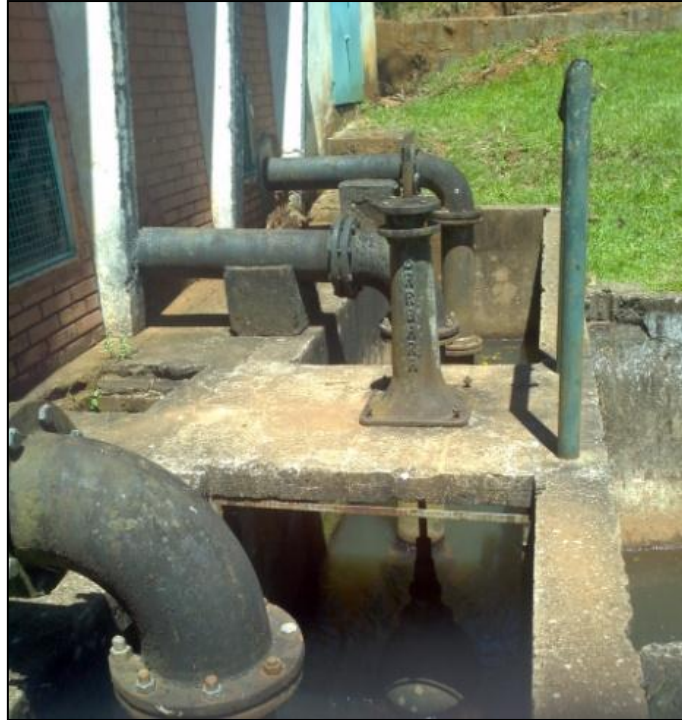
Figura 21: Poço de Sucção.
