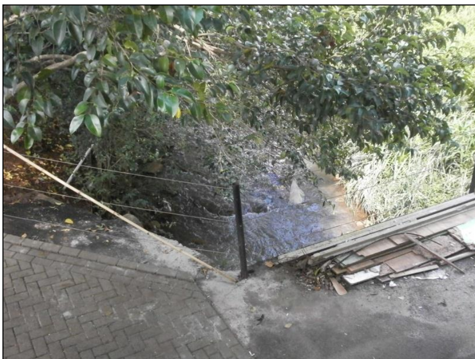
Figura 151: Aspecto do rio Xanxerê na Rua Nereu Ramos a Montante Já com Leito Natural de 3 m.
