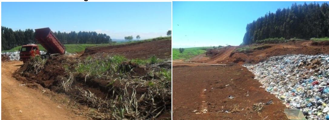
Figura 86: Frente de Trabalho do Aterro Sanitário.
