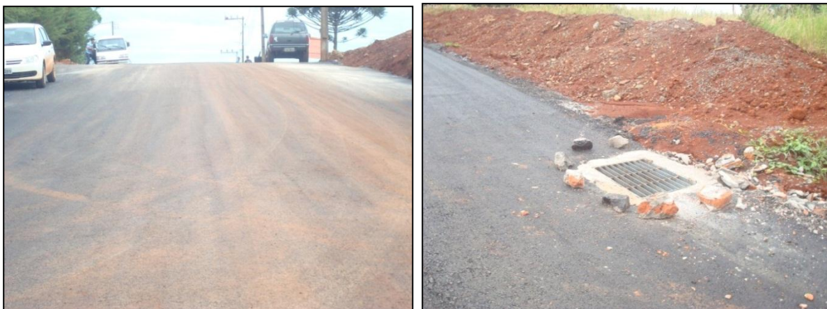
Figura 115: Pavimentação asfáltica Loteamento Andorinhas em Xanxerê. Detalhe para boca-de-lobo de via.
